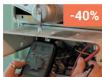
Contrôles réglementaires & sécurité incendie
